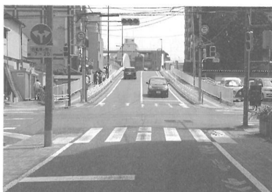
陸橋とみさき通り交差点付近の様子 (交差点C) ※6月17日撮影
