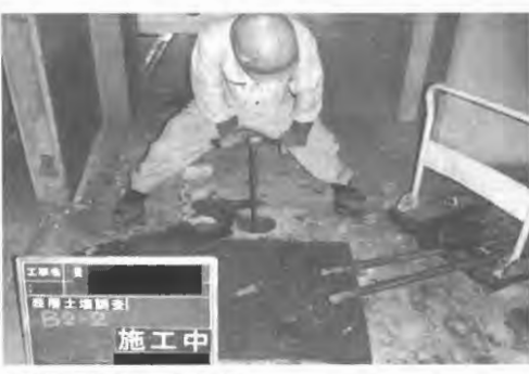
土壌汚染調査の状況
