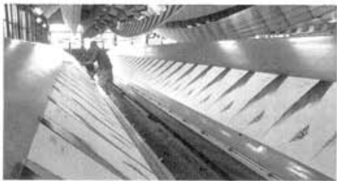
工場内での作業風景
